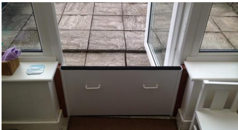
Figur 24, Exempel högvattenskydd i dörröppning
