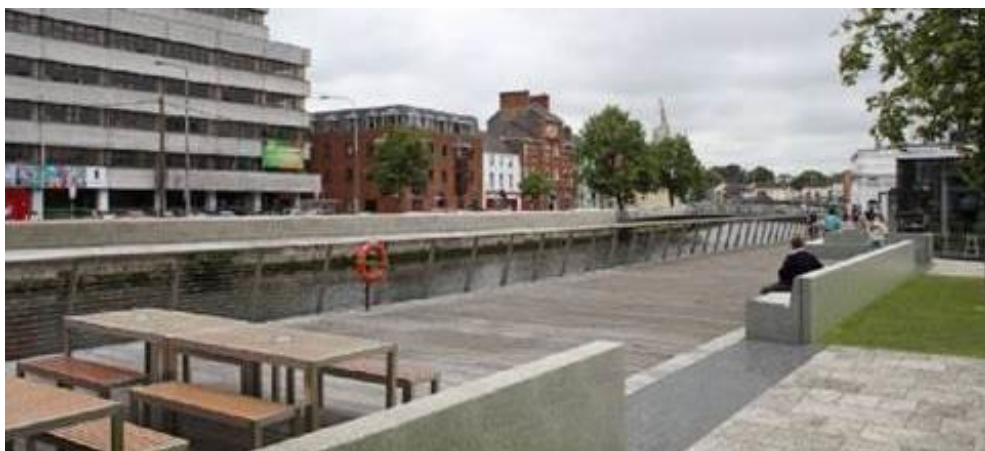
Figur 22, Översvämningsskydd i form av mur.
